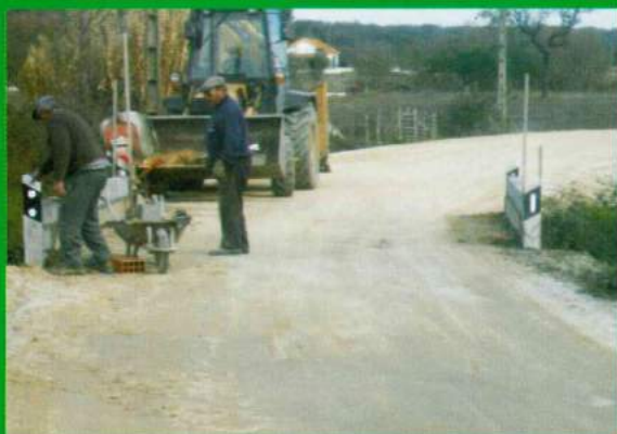
Pontão António Ricardo - Rua do Moinho / Brejoeira Construção de Paredes, Colocação de Reflectores e Pintura
